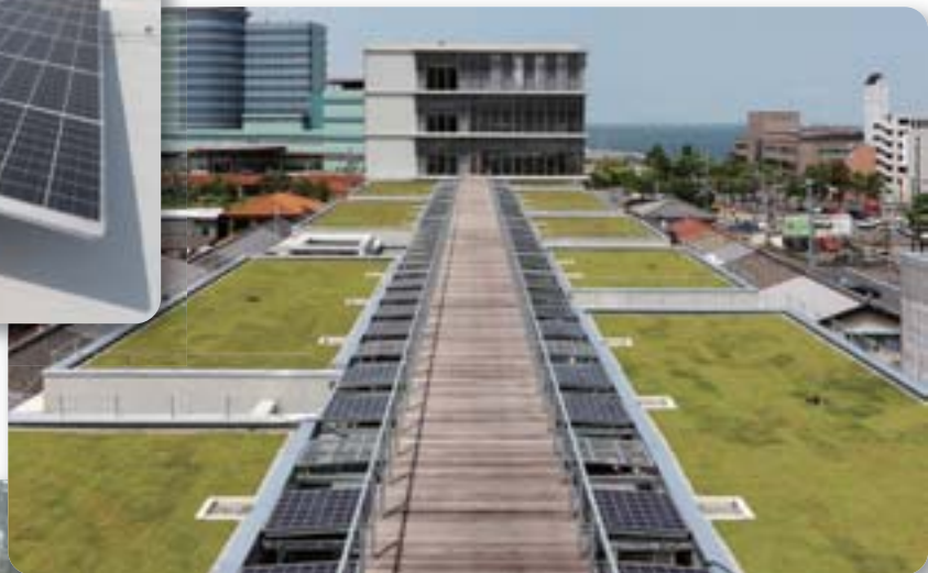
屋上緑化と太陽光発電パネル(しがぎん浜町研修センター)
