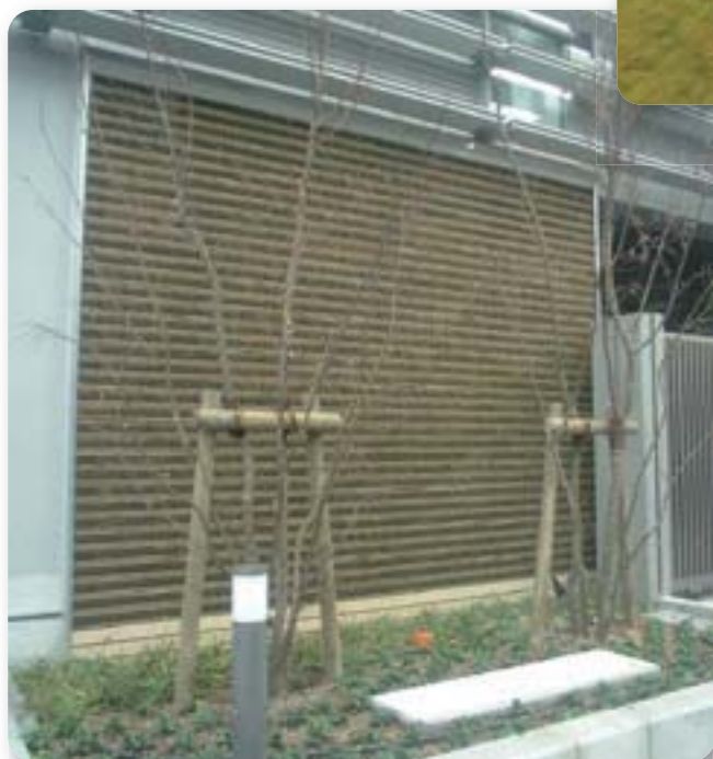
壁面緑化(しがぎん浜町研修センター)
